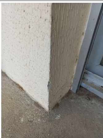
Prélèvement - P11 : MARENGO INTERNAT / RDC / FACADES / TERRASSES - Enduit- (Absence d'amiante)
