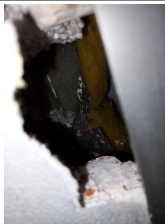
Prélèvement - P26 : MARENGO INTERNAT / R+1 / CH 113 - Isolant- (Absence d'amiante)
