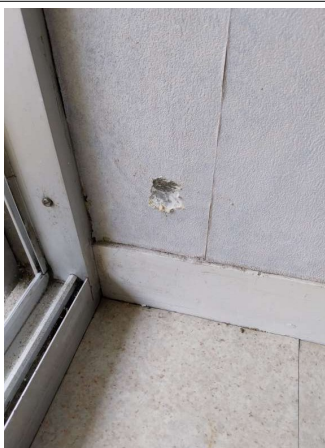
Prélèvement - P33 : MARENGO INTERNAT / R+3 / CH 316 - Enduit- (Absence d'amiante)
