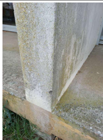
Prélèvement - P10 : MARENGO INTERNAT / RDC / FACADES / TERRASSES - Enduit- (Absence d'amiante)
