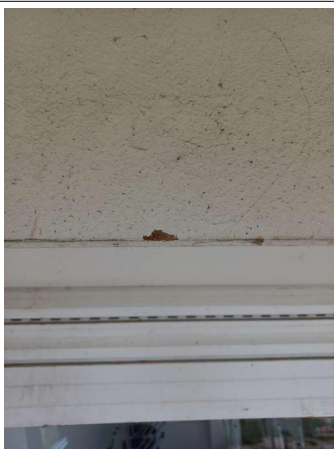
Prélèvement - P13 : MARENGO INTERNAT / RDC / FACADES / TERRASSES - Peinture- (Absence d'amiante)
