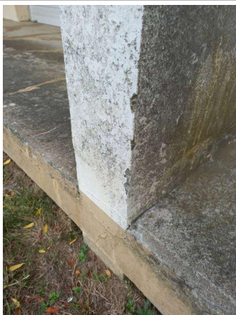
Prélèvement - P1 : MARENGO INTERNAT / RDC / FACADES / TERRASSES - Enduit- (Absence d'amiante)
