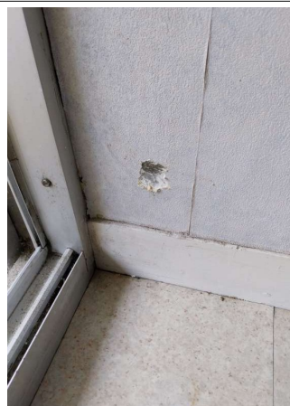
Prélèvement - P32 : MARENGO INTERNAT / R+3 / CH 317 - Enduit- (Absence d'amiante)
