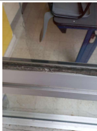
Prélèvement - P6 : MARENGO INTERNAT / RDC / FACADES / TERRASSES - Joint- (Présence d'amiante)
