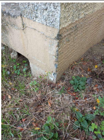
Prélèvement - P7 : MARENGO INTERNAT / RDC / FACADES / TERRASSES - Enduit- (Absence d'amiante)
