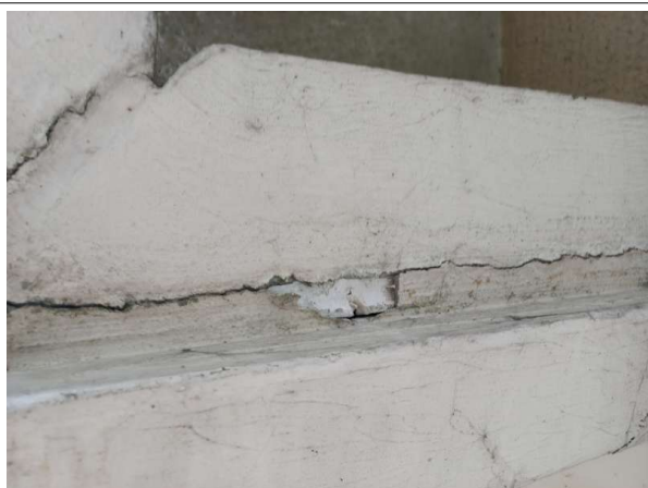
Prélèvement - P3 : MARENGO INTERNAT / RDC / FACADES / TERRASSES - Joint de dilatation- (Absence d'amiante)
